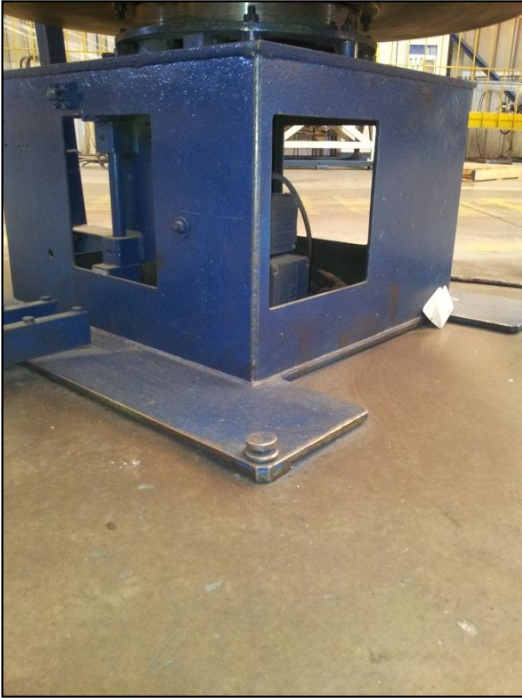
Imagen 21 Anclaje rollo de alambre sin aislación.
