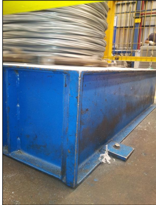
Imagen 22 Anclaje de rollo sin aislación.
