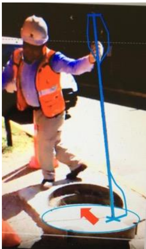
Imagen 30: Análisis de movimientos durante el desplazamiento de la tapa por parte de los operadores
