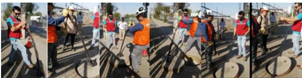
Imagen 27: Operadores probando desenganchar y movilizar la tapa con Chuzo 2.0
