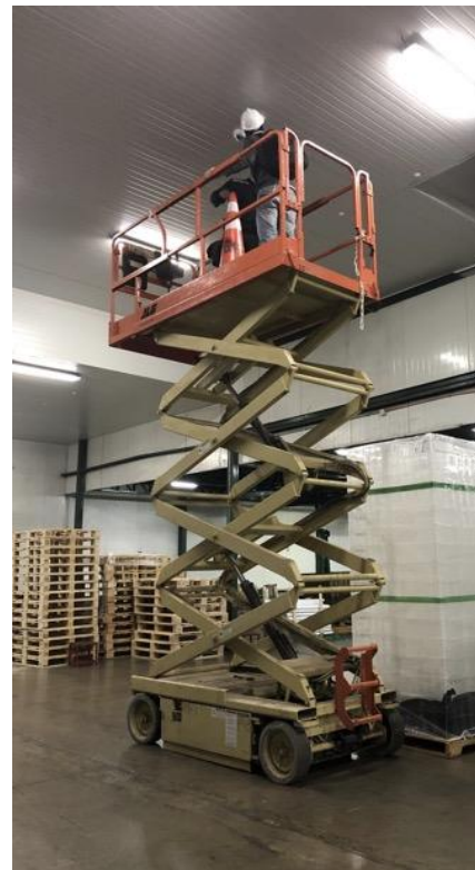
Fotografía 9. Instalación de cámaras
