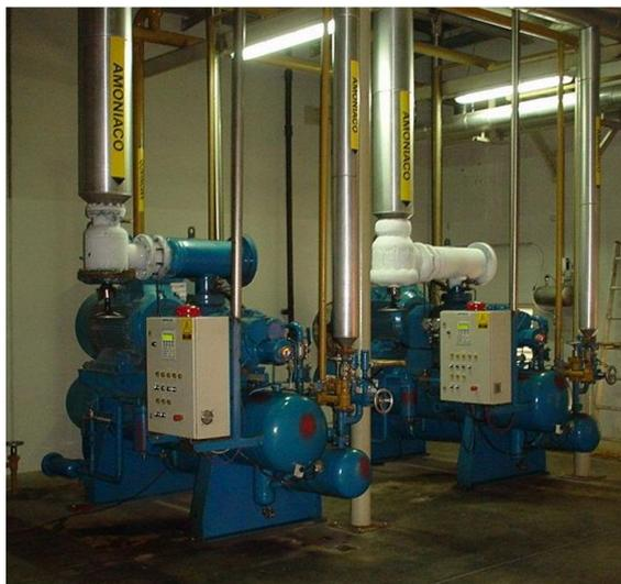
*El monitoreo y registro de las variables de operación del compresor debe incluir presión y temperatura de succión, presión y temperatura de descarga, presión de aceite, amperaje y revoluciones; además del ruido, como forma de controlar su estado de mantención.*
