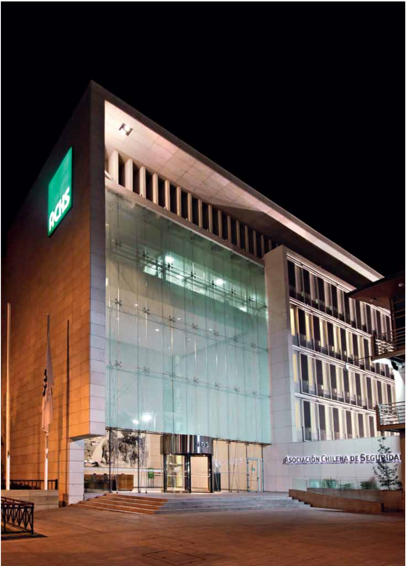
EDIFICIO CORPORATIVO ACHS - CONSTRUÍDO CON UN DISEÑO INTEGRAL DE EFICIENCIA ENERGÉTICA, QUE UTILIZA MENOS ENERGÍA SIN SACRIFICAR CONFORT O PRODUCTIVIDAD.
